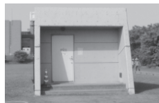
【調圧水槽入口】
